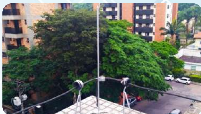
Instalação de hastes de captação
