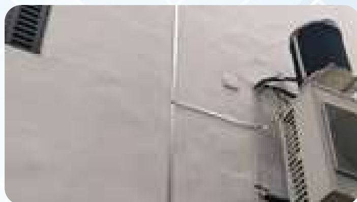
Criação de descidas de alumínio para aterramento
